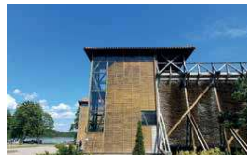
Gradierwerk Goldap Gradierwerke wurden früher zur Salzgewinnung genutzt. Durch eine spezielle Bauweise wurde das Wasser so weit verdunstet, dass der Salzgehalt stieg. Dabei spielten Sonne, Wind und trockene Luft eine entscheidende Rolle. Heute sind Gradierwerke vor allem in Kurorten zu finden, wo sie gezielt für therapeutische Anwendungen eingesetzt werden.
